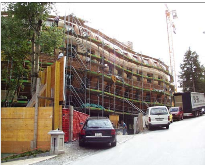
Ansicht auf die Nordwand von der Zufahrt zur Tiefgarage.
