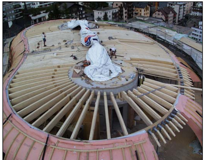
Sicht vom Kran auf die Dachoberfläche, links die Nordwand, rechts die Südwand mit den Dachvorsprüngen des Balkones.
