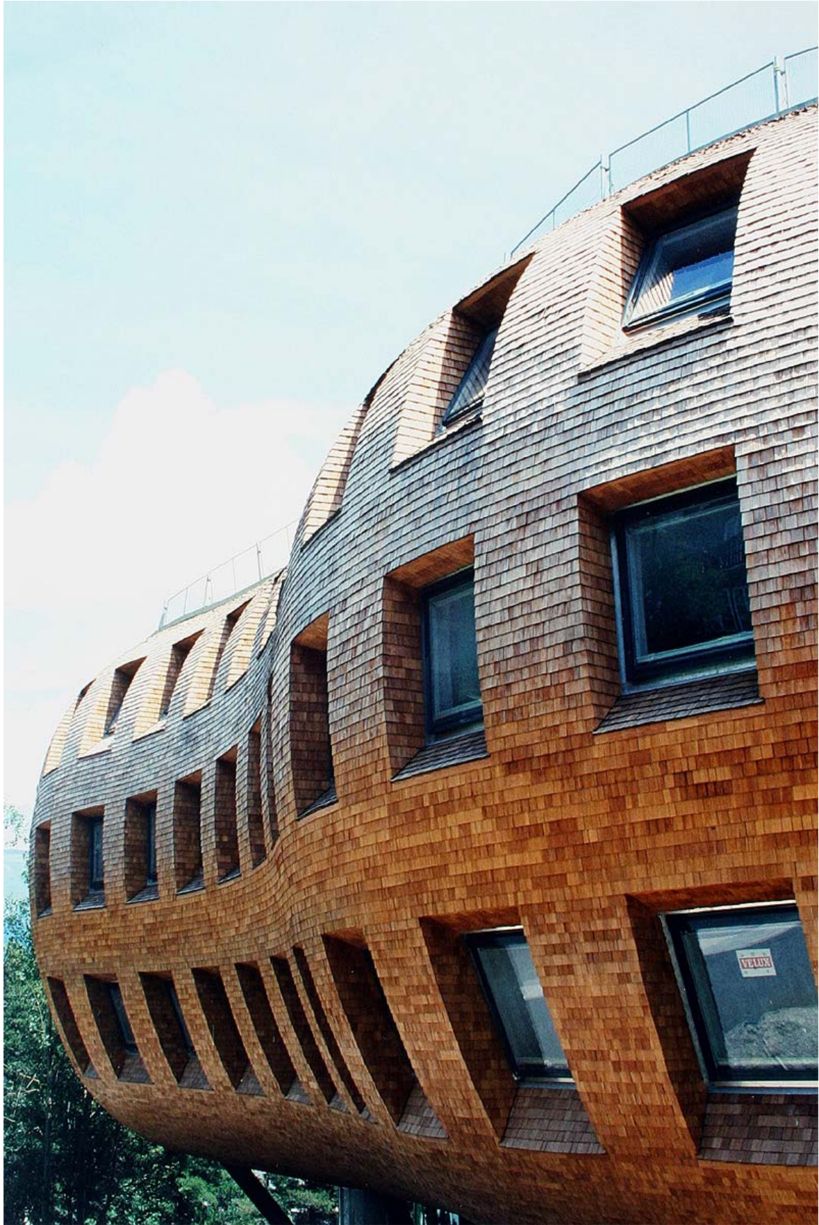
Wie ein massgeschneidertes Kleid schmiegt sich die Schindelhaut (Lärchenholz) an den bauchig geformten Holzkörper des Appartementhauses Chesa Futura in St. Moritz
