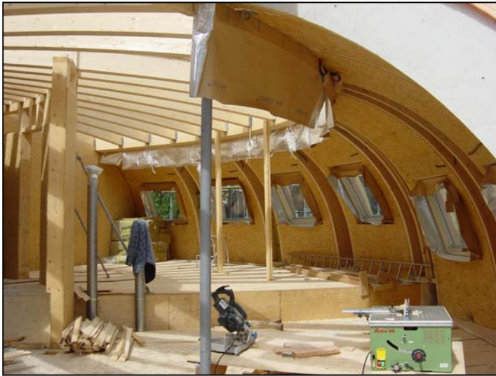
Fast komplett montierte Nordwand des 3. OG mit angeschlossenen Dachsparren.
