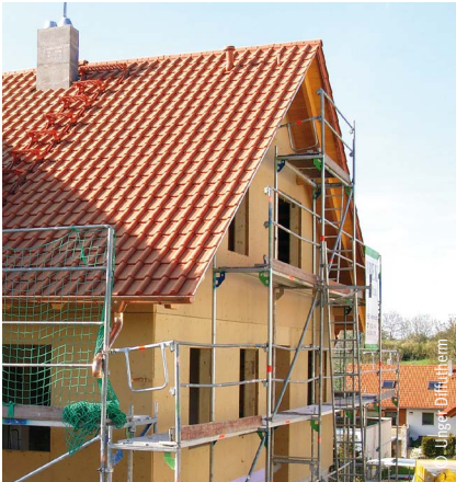
Fassade mit WDVS
