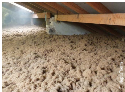
Seegrassschüttung oberste Geschossdecke
