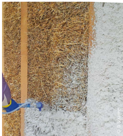
Aufbringen von Kalkputz auf eine Strohwand
