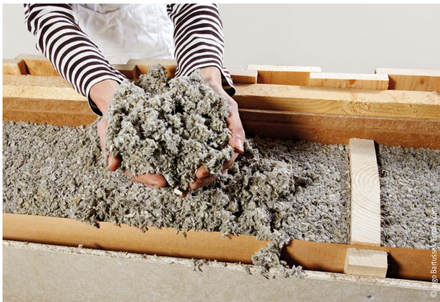
Zelluloseeinblasdämmung in einer Außenwand
