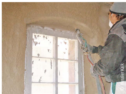
Aufbringen von Kalkputz mit einer Putzmaschine
