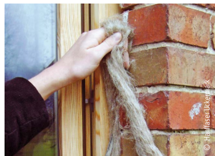
Ausstopfen von Bauteilfugen mit Hanf
