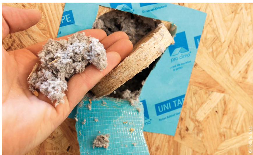
Dämmung mit Zellulose
