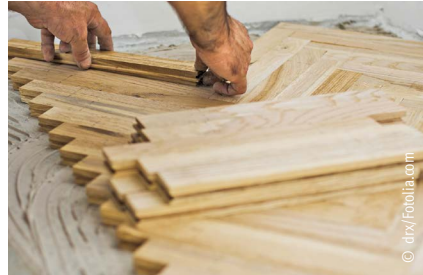
Verlegung von Stabparkett
