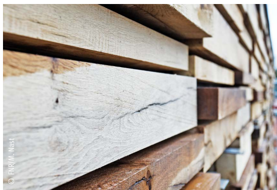
Holzfassade des FNR-Neubaus aus Eiche
