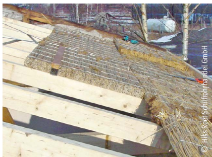
Aufdachdämmung mit Schilfrohrdämmplatten
