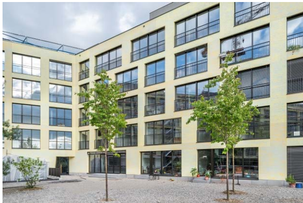
Wohnhof auf dem Tramhallendach Bild: M. Egloff
