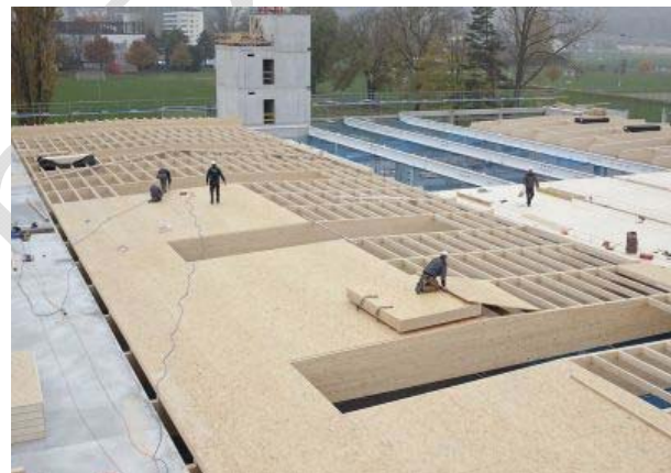
Montage der Dachelemente
