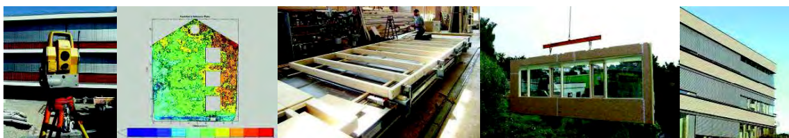
Abb. 2: Ablauf – Vermessung, Unebenheitskontrolle, Produktion, Montage, Betrieb
